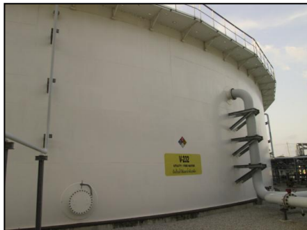
ภาพที่ 2.2-21 ระบบถังเก็บกักน้ำสำรองเพื่อการดับเพลิง
